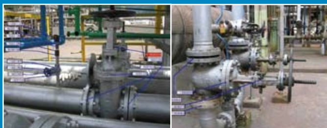
Identificação dos equipamentos por fotografia digital
